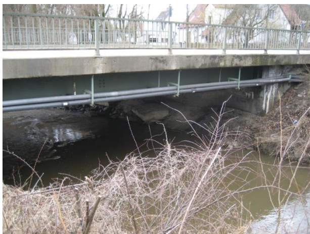
Abbildung 17: Brücke Staatsstraße – Einlauf (OW)
