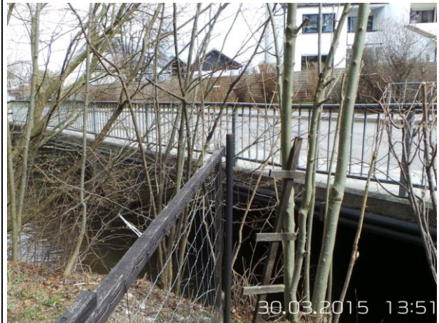
Abbildung 16: Bulachgraben-Brücke (Ansicht OW)
