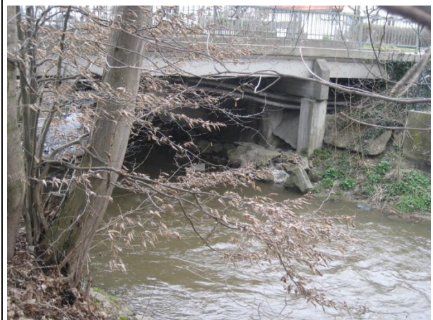
Abbildung 18: Brücke Staatsstraße – Auslauf (UW)
