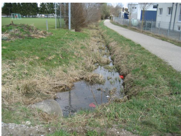
Abbildung 9: Entwässerungsgraben (am Sportplatz)
