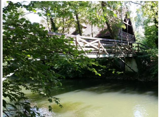
Abbildung 8: Fußgängerbrücke am Amperkanal
