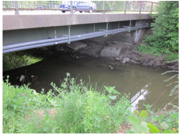
Brücke über den Bulachgraben an der Brucker Straße; Blick nach Norden
