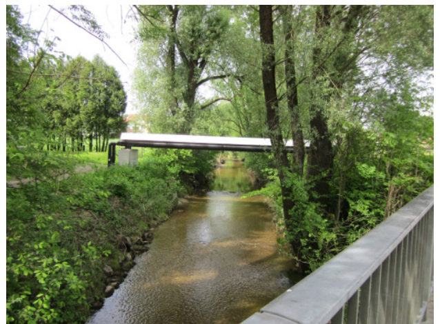
Bulachgraben mit Ufergehölz und Verbau; Blick von Brücke an der St.-Vitus-Straße nach Norden
