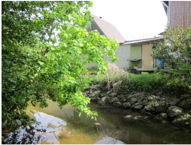
Bulachgraben zw. Brücke St.-Vitus-Straße und Brucker Straße; ufernahe Bebauung, Böschungsverbau; Blick nach Südosten
