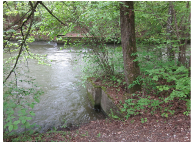
Amperkanal mit gemauerter Uferböschung; Blick nach Süden
