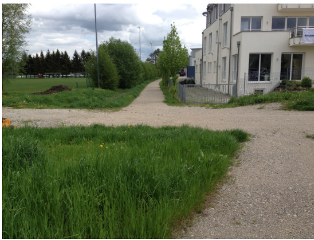
Beginn Baustrecke: Sportplätze, offener Graben, Gewerbe; Blick nach Osten
