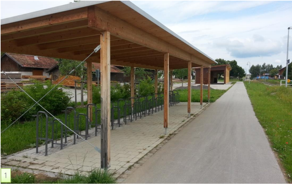
Bild 1: Die Zufahrt zur Radabstellanlage an einem Bahnhof erfolgt über einen von der Fahrbahn weit abgesetzten Geh- und Radweg. Die Verkehrswege sind frei und sicher. Positiv ist auch die Lage sehr nahe am Bahnsteig.
